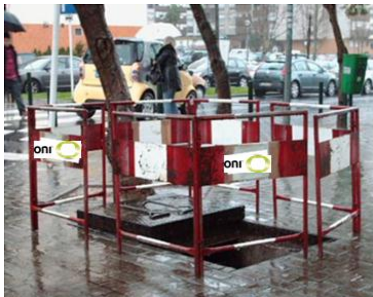
Imagem 1. Exemplo de Sinalização da entrada na Câmara de Visita
